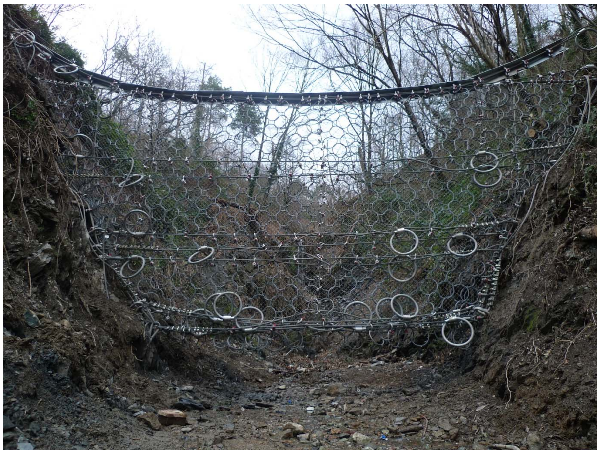
Figura 1-1: Installazione tipo di barriera contro le colate detritiche - Modello VX060L-H4
